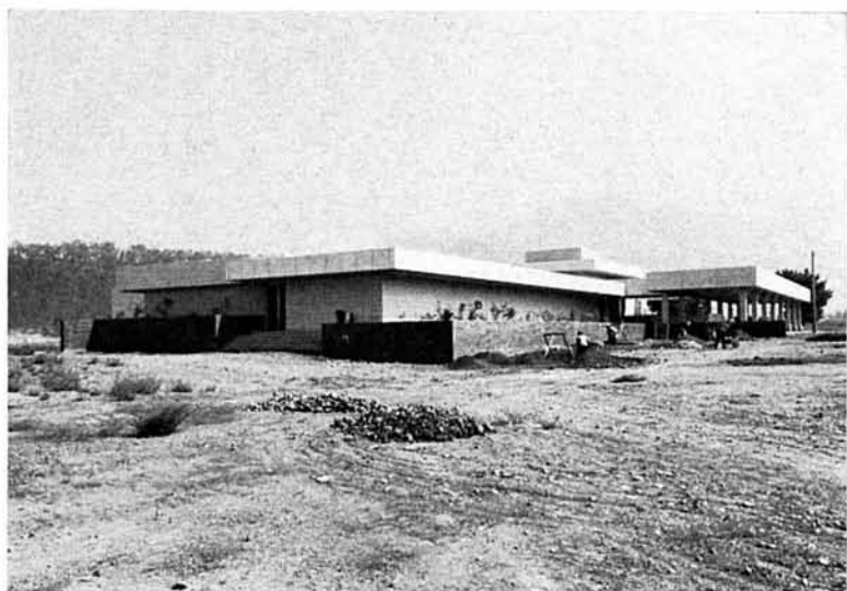
Fig. 7: Bâtiment du Centre de Santiago-Vitacura, côté, sud-est.
